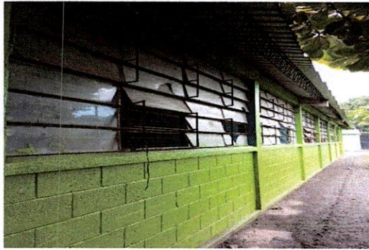
Foto 3: Sustitución de estructura de metal de Ventana
