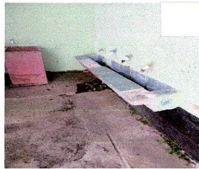
Foto 6: Sustitución de lavamanos
