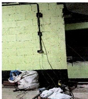
Foto 4: Sustitucion de interruptores dobles
