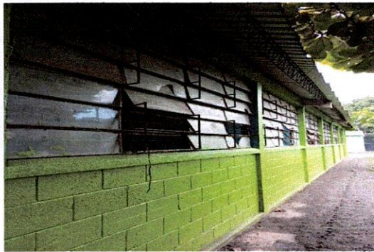
Foto 3: Sustitucion de estructura de metal de Ventana
