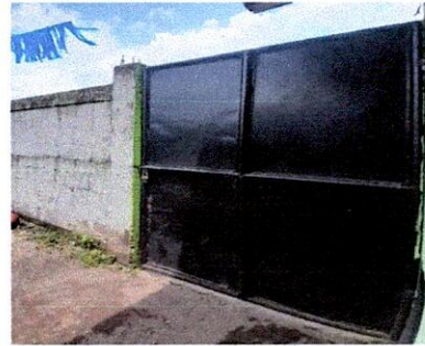
Foto 2: Sustitución de porton de metal
