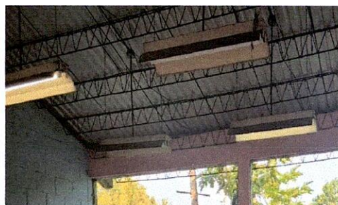
Foto 2: Sustitución de Lámparas
