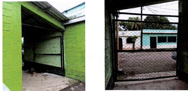
Foto 4: Sustitucion de porton de metal
