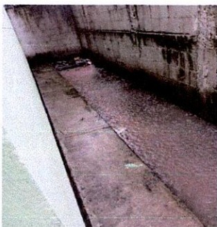
Foto 3: Sustitución de Cemento Liquido
