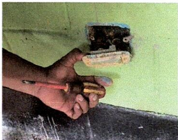
Foto1: Sustitucion de tomacorrientes dobles
