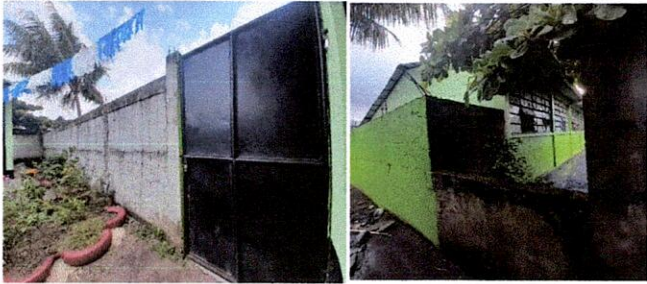
Foto 1: Reparación muro perimetral de Blok lado de adentro y de afuera
