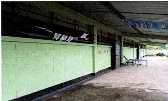
Foto 5: Sustitución de balcones de metal
