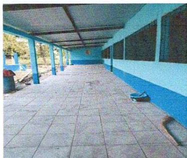
Foto 5: Sustitución de piso
