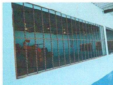
Foto 4: Sustitución de balcones de metal
