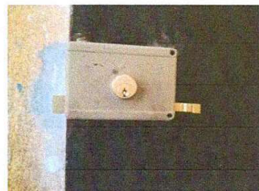
Foto 2: Sustitución de chapa
