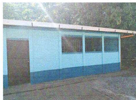
Foto 6: Sustitución de canal de metal
