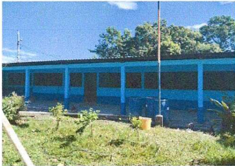
Foto 7: Pintura en muros exteriores e interiores
