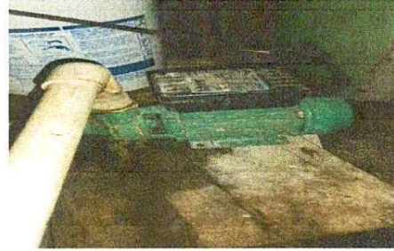
Foto 8: Sustitución de bomba de agua
