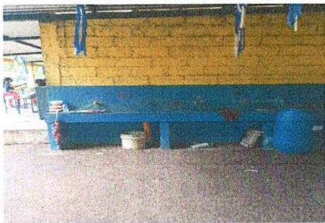
Foto 5: Sustritiución de azulejo y llaves de chorro
