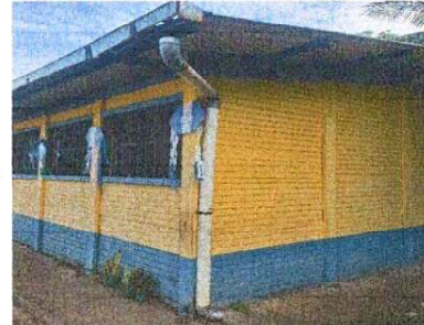
Foto 2: Suministro e instalación de bajadas pluviales
