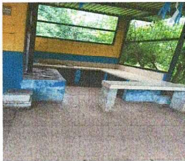
Foto 3: Sustritiución de piso
