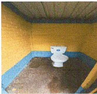
Foto 9: Sustitución de inodoros y migitorio
