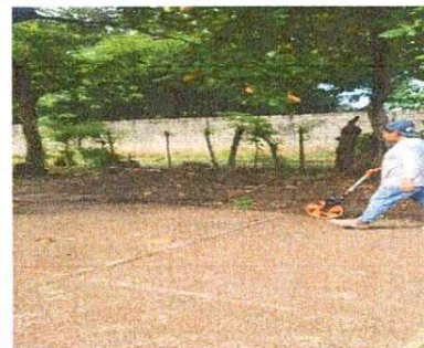
Foto 6: Sustritiución de cerco de alamre de puas
