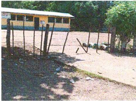
Foto 7: Fabricación e instalación de porton
