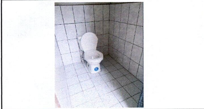
Foto 1: Baño y azulejo terminado
