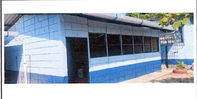
Foto 4: Instalación terminada de los canales de agua
