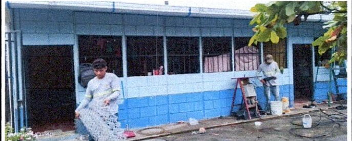
Foto 2: Limpieza y retoques de pintura en el exterior de la escuela
