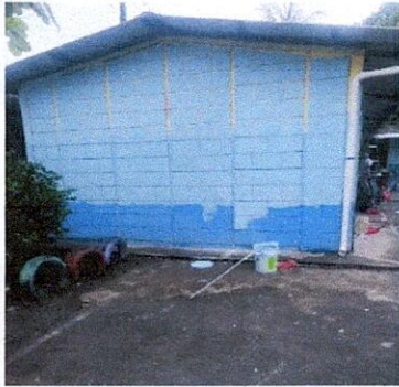
Foto 1: Pintado de paredes de la escuela de preprimaria
