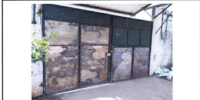
Foto 6: Restauración de lijado, enderezado y perfilado del porton principal de la escuela
