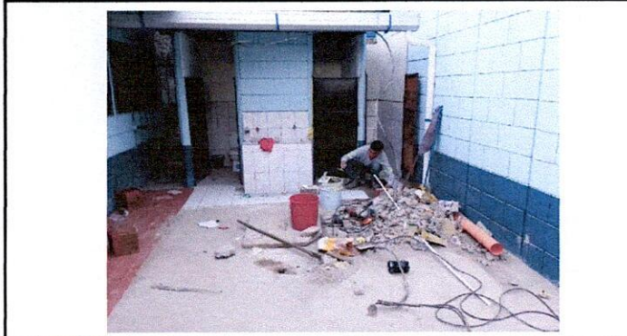
Foto 3: Instalación de piso y azulejo ceramico en el baño
