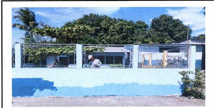
Foto 5: Instalación de reja en el muro perimetral del area de preprimaria
