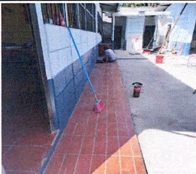
Foto 5: Instalación de pisos en el pasillo
