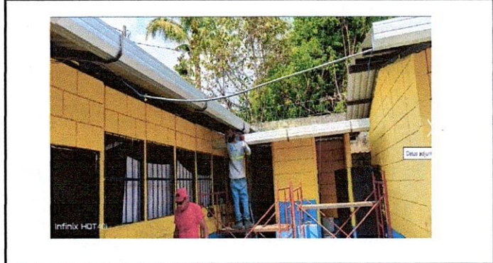
Foto 4: Instalación de canal PVC
