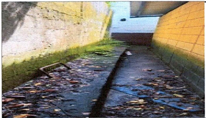
Foto 4: Pintura en muros interior y exterior
