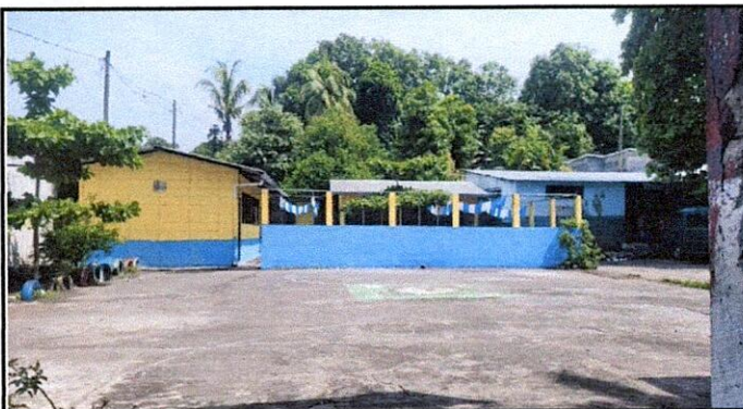
Foto 5: Reparacion de tubo hg y malla galvanizada
