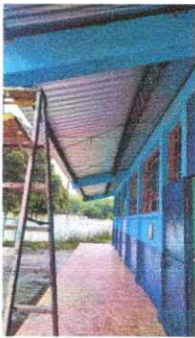
Foto 9:sustitucion de lamina aula 1 y 2
