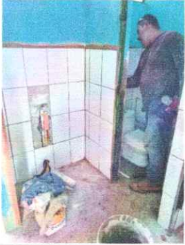
Foto 7 :Sustitucion de azulejo lavamanos de niños
