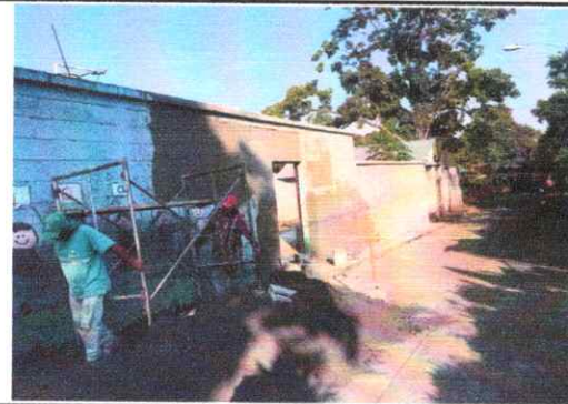
Foto 6: Repello de paredes interior y exterior de la escuela
