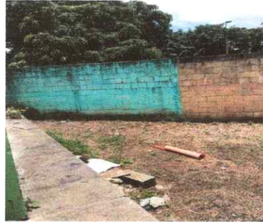
repello interior de la escuela
