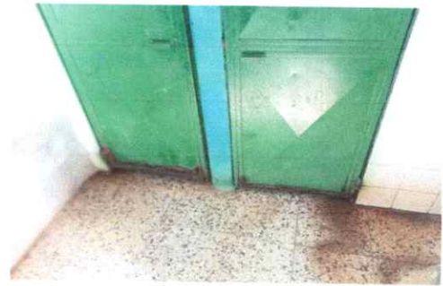
Foto 2: puerta de sanitarios de niños
