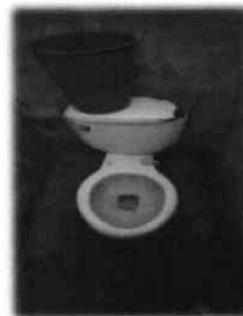
Foto 4: Se cambiarán e instalarán 4 unidades de inodoros, ya que se encuentran quebrados y deteriorados.
