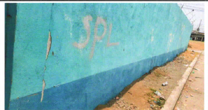
FOTO 9: PINTURA DE MUROS DE EXTERIOR DE ESTABLECIMIENTO
