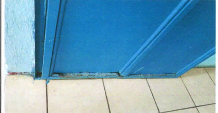
FOTO 2: REPARACIÓN DE PUERTAS
