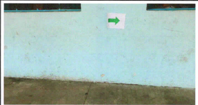
FOTO 8: PINTURA DE MUROS EXTERIORES DE SALONES
