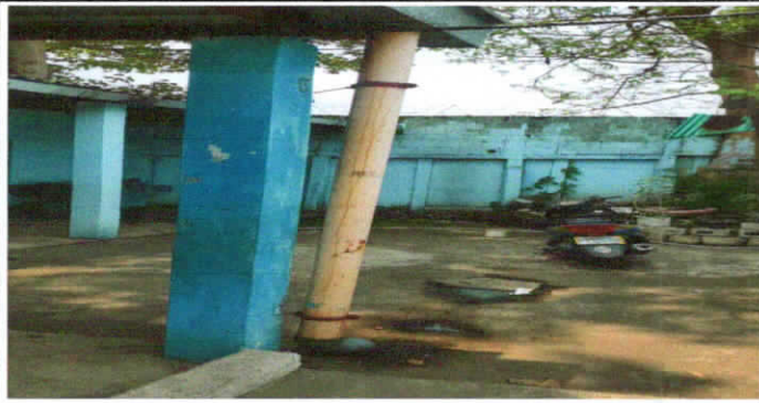
FOTO 7: SUSTITUCIÓN DE PESCANTE O SOPORTE DE CANAL
