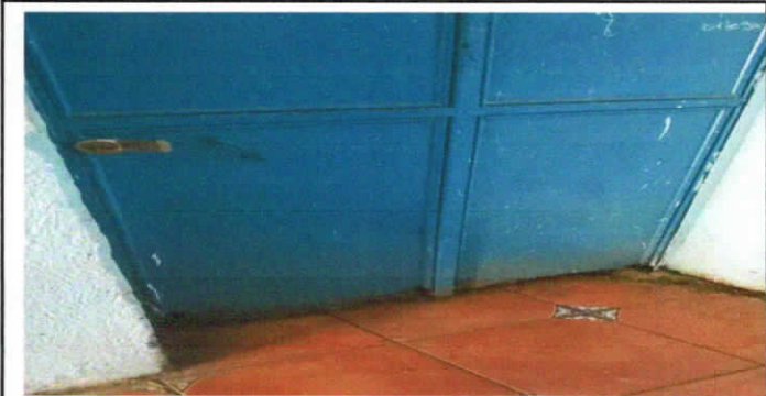
FOTO 4: SUSTITUCIÓN DE PUERTA DE BODEGA
