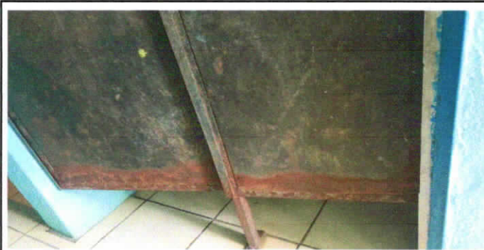
FOTO 5: SUSTITUCIÓN DE PUERTA DE SANITARIO
