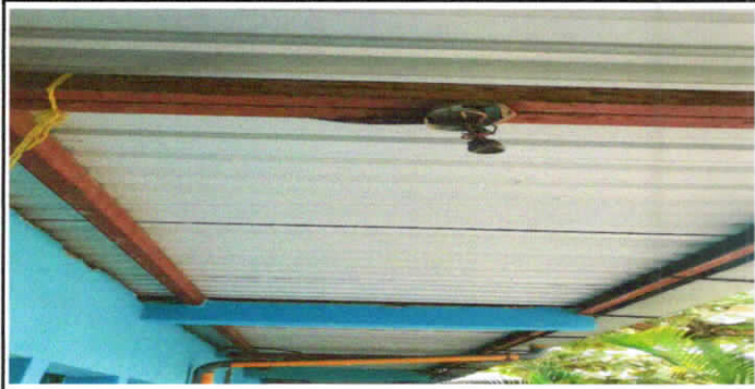
FOTO 13: SUSTITUCIÓN DE PLAFONERAS
