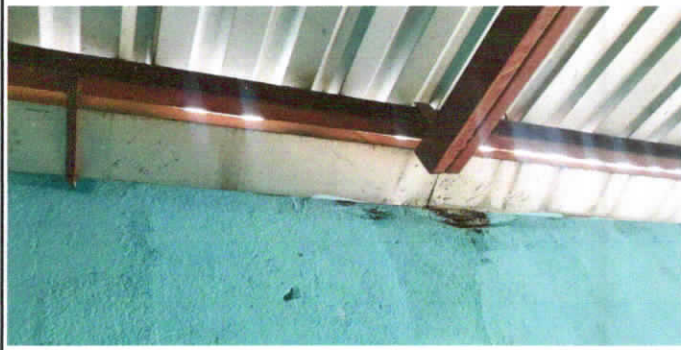
FOTO 1: MANTENIMIENTO DE ESTRUCTURA DE METAL
