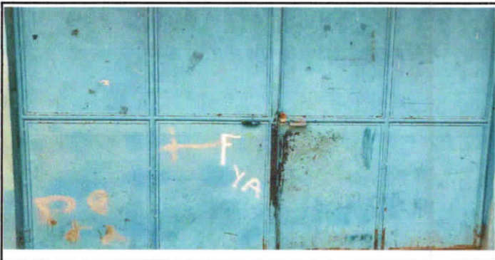
FOTO 11: MANTENIMIENTO A PORTON
