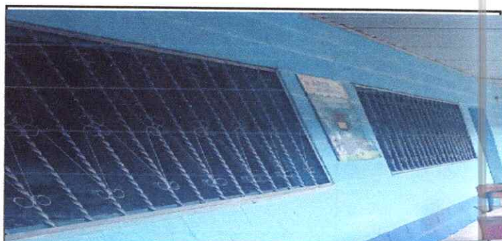
Foto 12: SUSTITUCIÓN DE 2 BALCONES DE METAL LADO DELANTE DEL SALÓN
