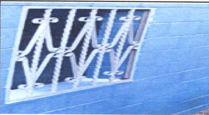
Foto 9: SUSTITUCIÓN DE BALCONES DE METAL LADO DERECHO DE LA
