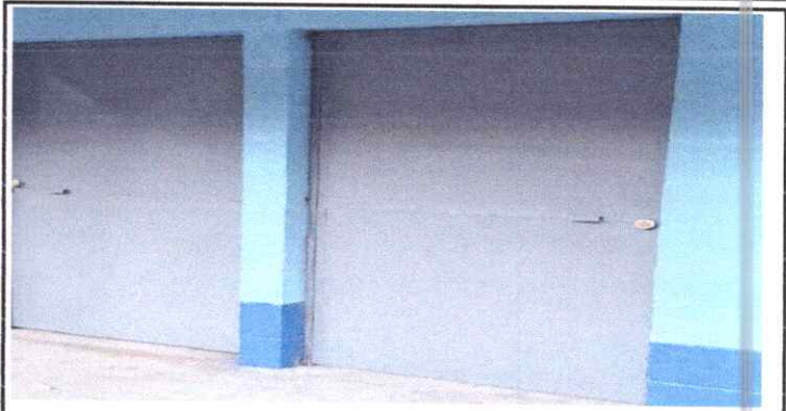
Foto 14: MANTENIMIENTO DE 2 PUERTAS, PINTURA Y CAMBIO DE CHAPA SALÓN
