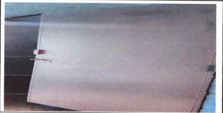
Foto 11: SUSTITUCIÓN DE 2 PUERTAS EN SERVICIOS SANITARIOS DE NIÑAS
