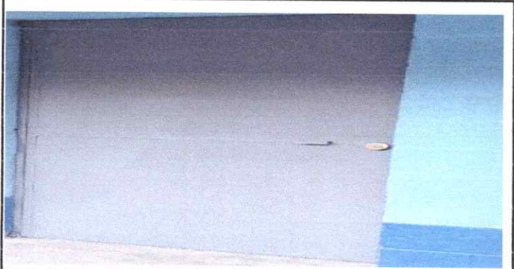
Foto 13: MANTENIMIENTO DE PUERTA, PINTURA Y CAMBIO DE CHAPA BODEGA
