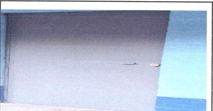
Foto 15: MANTENIMIENTO DE PUERTA, PINTURA Y CAMBIO DE CHAPA BIBLIOTECA
