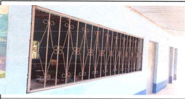
Foto 3: SUSTITUCIÓN DE BALCONES DE METAL LADO DE FRENTE SALÓN 3
