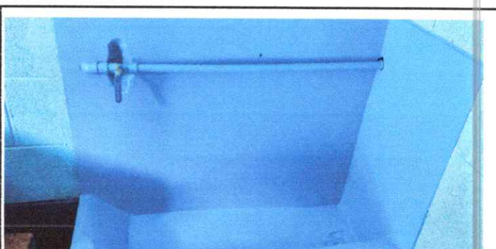
Foto 18: SUSTITUCIÓN DE LLAVE EN MINGITORIO
