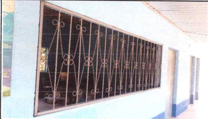
Foto 7: SUSTITUCIÓN DE BALCONES DE METAL LADO DELANTE SALON
