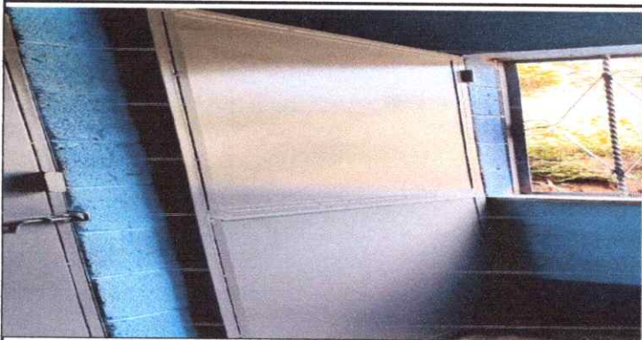
Foto 9: SUSTITUCIÓN DE 2 PUERTAS EN SERVICIOS SANITARIOS DE NIÑOS
