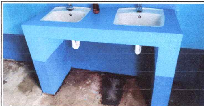
Foto 15: SUSTITUCIÓN DE LAVAMANOS EN EL SANITARIO DE NIÑAS
