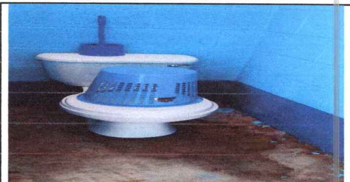
Foto 16: SUSTITUCIÓN DE ACCESORIOS INODORO DEL SANITARIO DE LOS NIÑOS
