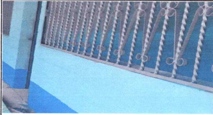
Foto 1: SUSTITUCIÓN DE BALCONES DE METAL LADO DE FRENTE SALÓN
