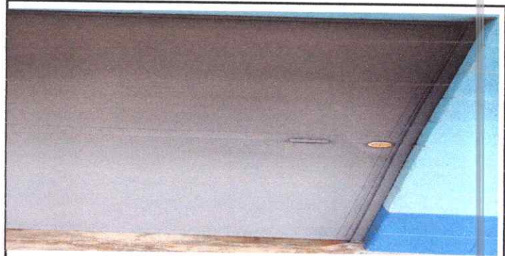
Foto 10: SUSTITUCIÓN DE PUERTA PRINCIPAL EN EL SANITARIOS DE NIÑOS
