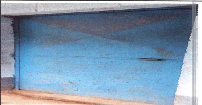
Foto 18: MANTENIMIENTO DE PUERTA, PINTURA Y CAMBIO DE CHAPA SALÓN 3
