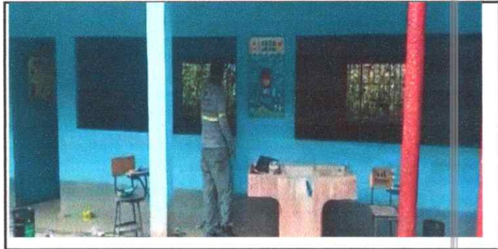
Foto 12: SUSTITUCIÓN DE 2 BALCONES DE METAL LADO DELANTE DEL SALÓN
