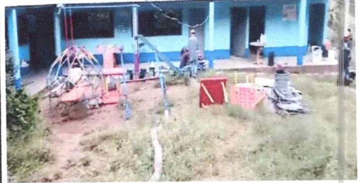
Foto 14: PINTURA EN MUROS EXTERIORES E INTERIORES
