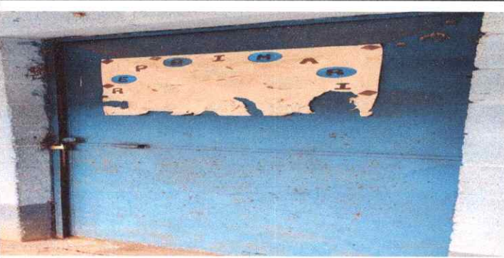
Foto 17: MANTENIMIENTO DE PUERTA, PINTURA Y CAMBIO DE CHAPA SALÓN 2
