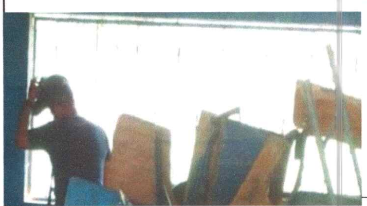
Foto 2: SUSTITUCIÓN DE BALCONES DE METAL LADO DE ATRÁS SALÓN 4
