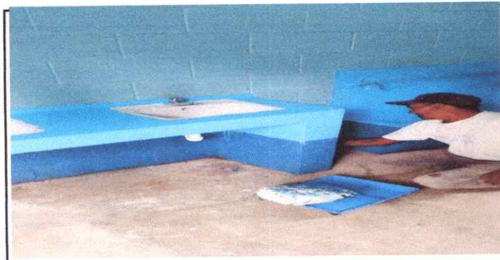
Foto 17: SUSTITUCIÓN DE LAVAMANOS EN EL SANITARIO DE NIÑOS
