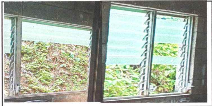
Foto 11: SUSTITUCIÓN DE 2 BALCONES DE METAL LADO DE ATRAS DEL SALÓN
