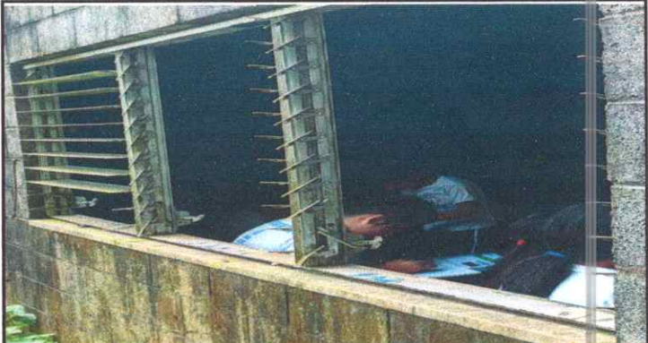
Foto 8: SUSTITUCIÓN DE BALCONES DE METAL LADO DE ATRAS
