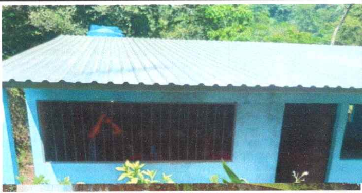
Foto1: SUSTITUCIÓN DE BALCONES DE METAL LADO DE FRENTE SALÓN 4
