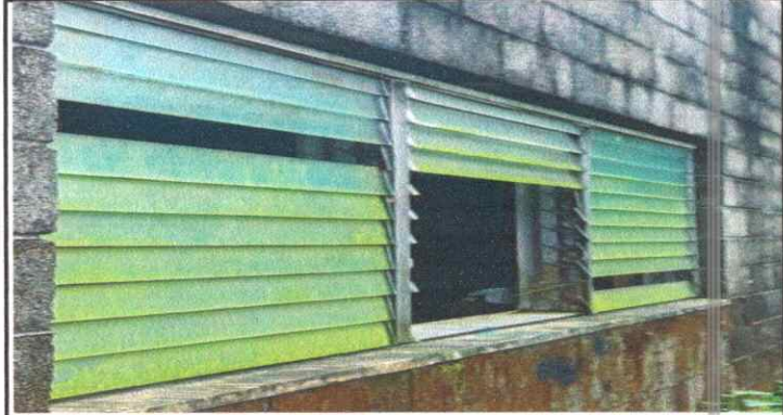
Foto 10: SUSTITUCIÓN DE BALCONES DE METAL LADO DE ATRAS
