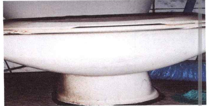
Foto 16: SUSTITUCIÓN DE ACCESORIOS INODORO DEL SANITARIO DE LOS NIÑOS
