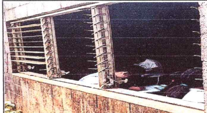
Foto 8: SUSTITUCIÓN DE BALCONES DE METAL LADO DE ATRAS
