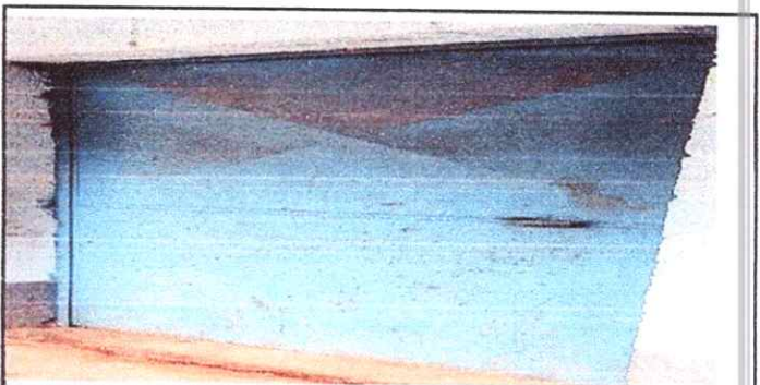
Foto 18: MANTENIMIENTO DE PUERTA, PINTURA Y CAMBIO DE CHAPA SALÓN 3
