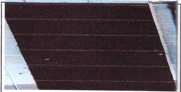
Foto 16: MANTENIMIENTO DE PUERTA, PINTURA Y CAMBIO DE CHAPA SALÓN 1
