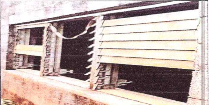
Foto 4: SUSTITUCIÓN DE BALCONES DE METAL LADO DE ATRÁS SALÓN 3
