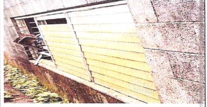
Foto 2: SUSTITUCIÓN DE BALCONES DE METAL LADO DE ATRÁS SALÓN 4
