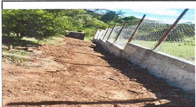
Foto 8: Reparación de muro perimetral de block con tubo hg y malla galvanizada, solares intermedias y columnas
