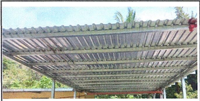
Foto 1: sustitución de lámina troquelada aluzinc calibre 26
