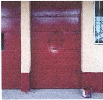
Foto 3: sustitución de puertas
