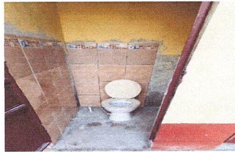
Foto 4: sustitución de piso ceramico y azulejo
