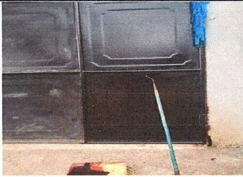
Foto 7: Mantenimiento a portones de metal
