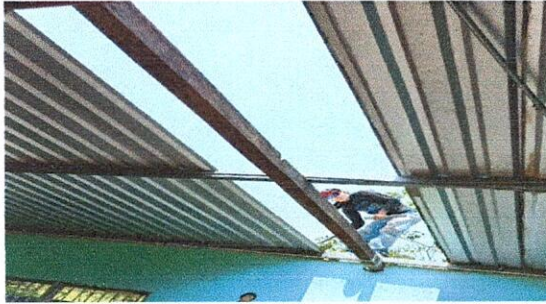
Foto1: sustitución de lámina troquelada aluzinc calibre 26
