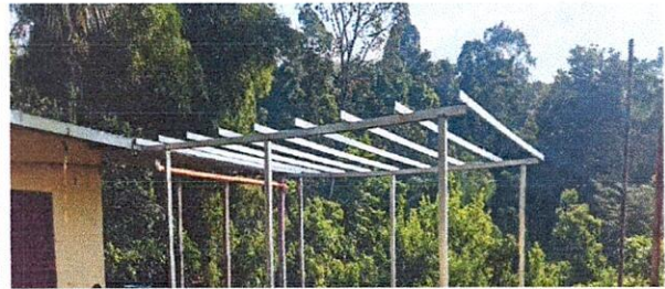
Foto 2: sustitución de estructura de soporte de metal por metal
