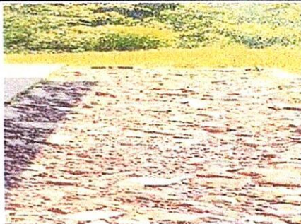
Foto 5: Reparación de piso de torta de concreto
