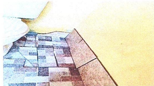
Foto 4: sustitución de piso ceramico y azulejo
