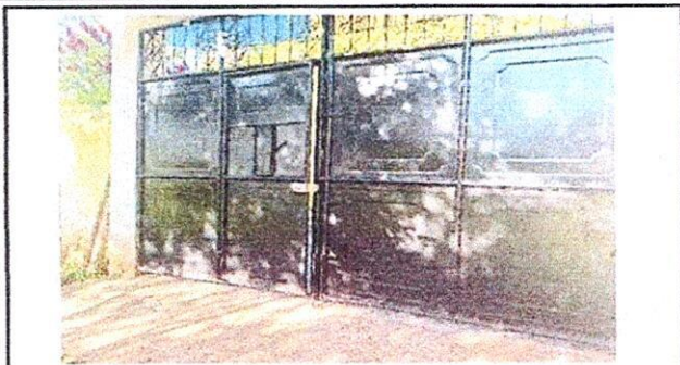
Foto 7: Mantenimiento a portones de metal
