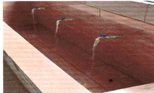
Foto 4: Sustitución de tubería línea principal
