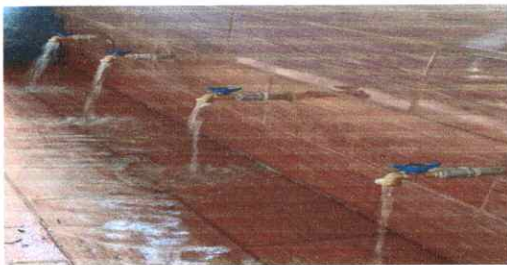
Foto 5: Sustitución de llave de chorro
