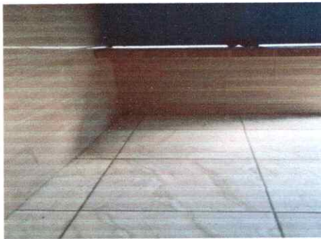
Foto 3: Sustitución de azulejo
