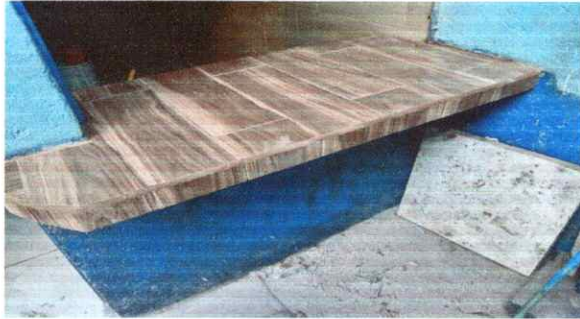
Foto 7: 20.7 Instalación de azulejo en estufa rural
