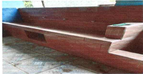
Foto 2: Sustitución de piso cerámico
