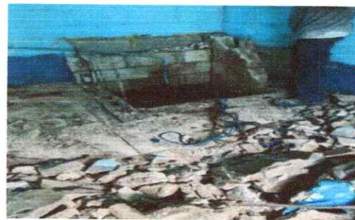
Foto 6: Reparación de cisterna de concreto
