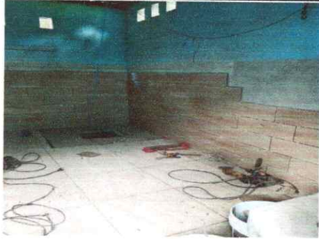
Foto 7: 20.7 Instalación de azulejo en estufa rural
