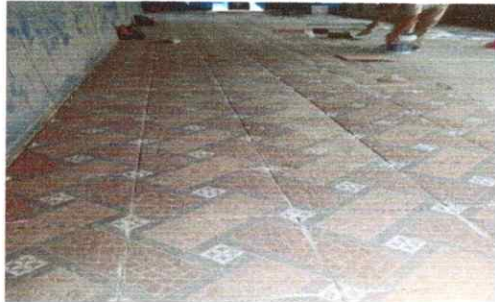
Foto1: Reparación de piso de torta de concreto
