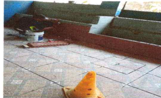
Foto 2: Sustitución de piso cerámico
