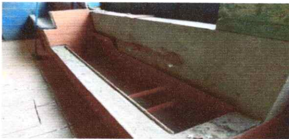
Foto 3: Sustitución de azulejo
