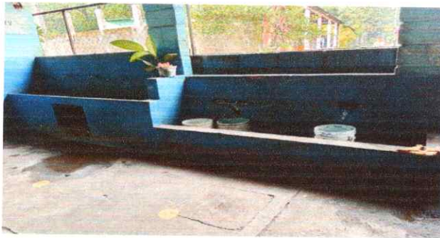
Foto 3: 13.1 Sustitución de Azulejo
