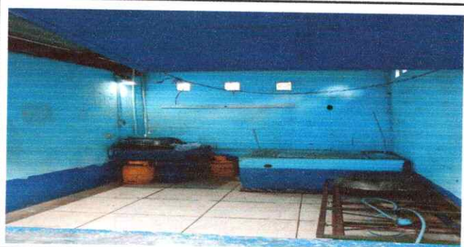
Foto 6: 18.4 Reparación de cisterna de concreto
