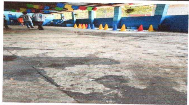
Foto 2: 6.8 Sustitución de piso cerámico
