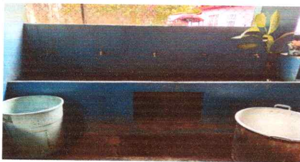
Foto 5: 14.13 Sustitución de llave de chorro
