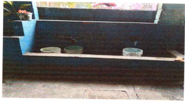
Foto 4: 14.9 Sustitución de tubería línea principal
