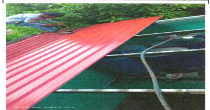
Mantenimiento a estructura de metal y cambio de 3 láminas
