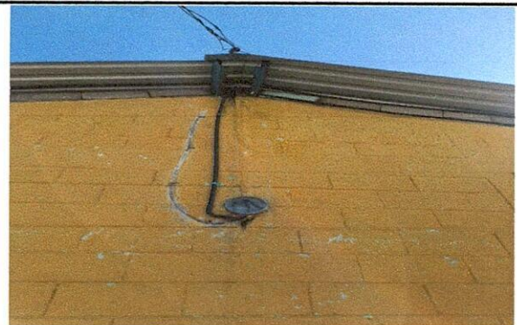
Foto 12: REPARACIÓN DE CABLEADO ELÉCTRICO
