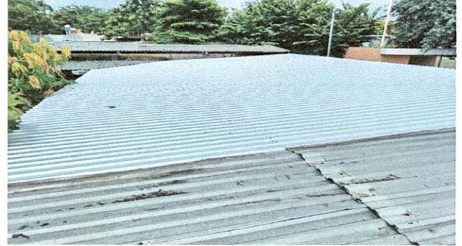
Foto 8: SUSTITUCIÓN DE LAMINA POR LAMINA TROQUELADA CALIBRE 26
