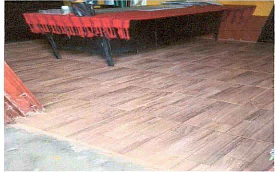
Foto 20: SUSTITUCIÓN DE PISO DE CEMENTO LÍQUIDO POR AZULEJO
