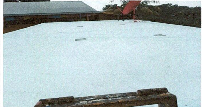
Foto 10: IMPERMEABILIZACIÓN DE LOSA
