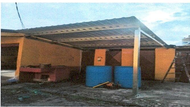
Foto 9: SUSTITUCIÓN DE LAMINA POR LAMINA TROQUELADA CALIBRE 26
