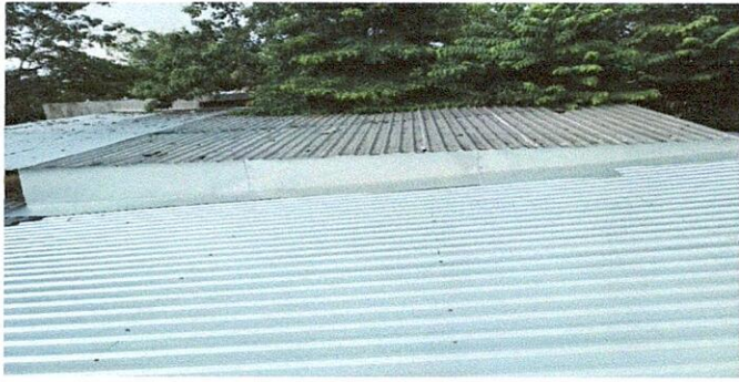
Foto7: SUSTITUCIÓN DE LAMINA POR LAMINA TROQUELADA CALIBRE 26
