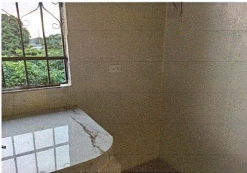
Foto 23: SUSTITUCIÓN DE TOMACORRIENTES DOBLES
