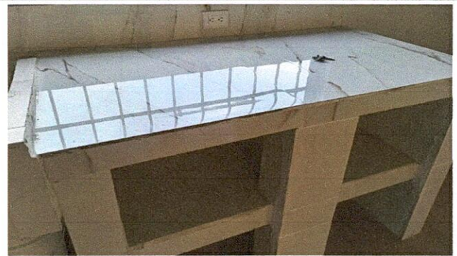
Foto 24: SUSTITUCIÓN DE AZULEJO
