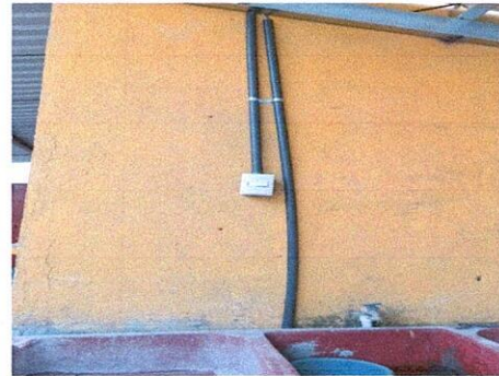
Foto 22: SUSTITUCIÓN DE INTERRUPTOR SIMPLE
