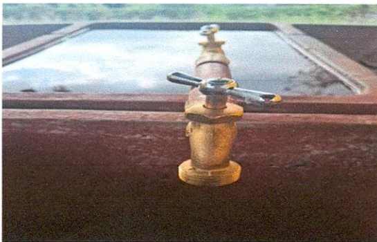
Foto 11: SUSTITUCIÓN DE LLAVE DE CHORROS
