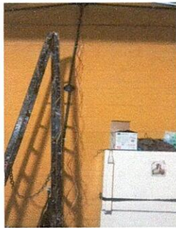
Foto 17: SUSTITUCIÓN DE INTERRUPTORES SIMPLES
