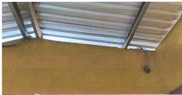
Foto1: SUSTITUCION DE LAMINA POR LAMINA TROQUELADA
