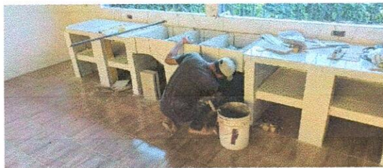
Foto 5: SUSTITUCION DE PISO DE GRANITO
