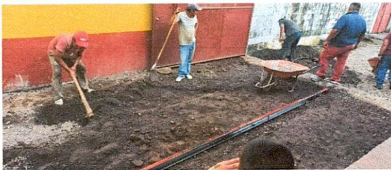
Foto 11: SUSTITUCION DE TUBERIA PRINCIPAL
