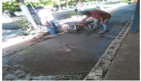
Foto 14: REPARACION DE PLANCHAS DE CONCRETO DE PATIO
