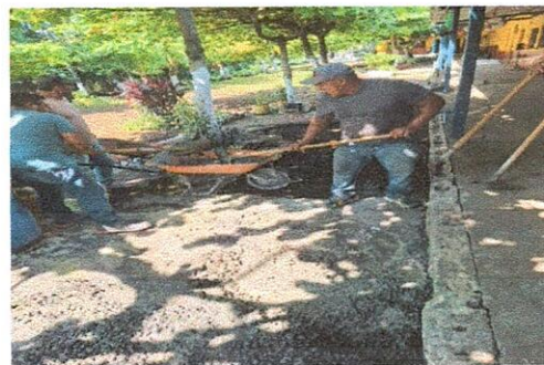
Foto 6: REPARACION DE BANQUETAS DE CONCRETO
