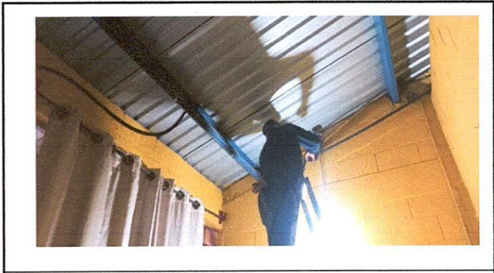
Foto 22: SUSTITUCION DE DUCTO ELECTRICO
