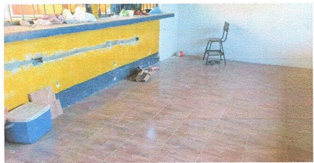
Foto 4: SUSTITUCION DE PISO DE CEMENTO LIQUIDO
