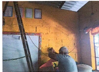
Foto 18: SUSTITUCION DE INTERRUPTORES DOBLES
