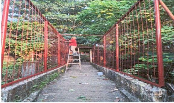
Foto 13: REPARACION DE TUBO HG MALLA GALBANIZADA
