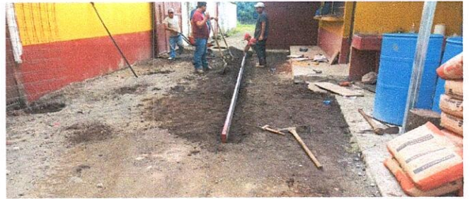
Foto 10: SUSTITUCION DE TUBERIAS PVC LINEA PRINCIPAL AGUAS NEGRAS
