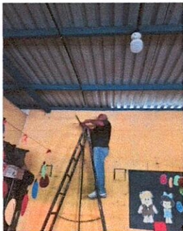
Foto 15: SUSTITUCION DE FOCOS AHORRADORES
