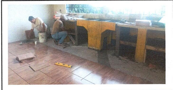
Foto 24: SUSTITUCIÓN DE PISO DE GRANITO
