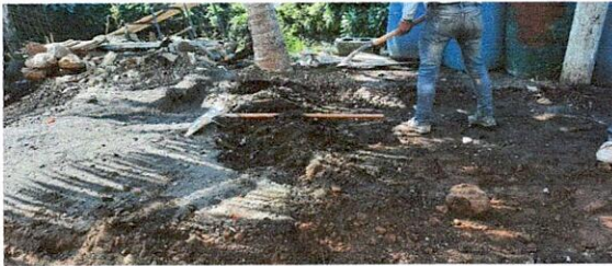
Foto 9: MANTENIMIENTO DE REPOSADERAS
