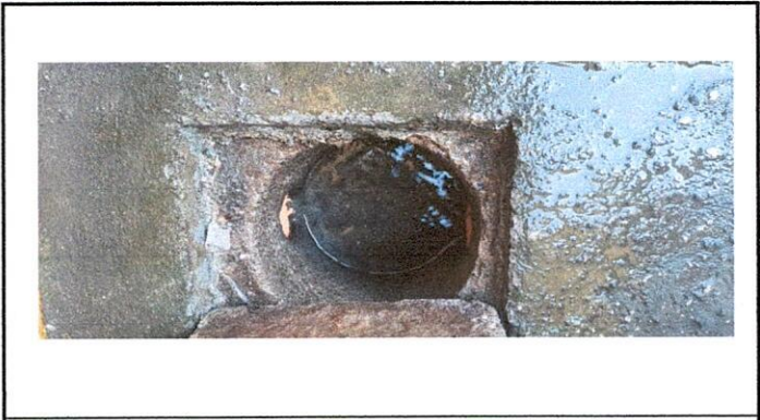
Foto 20: MANTENIMIENTO DE REPOSADERAS
