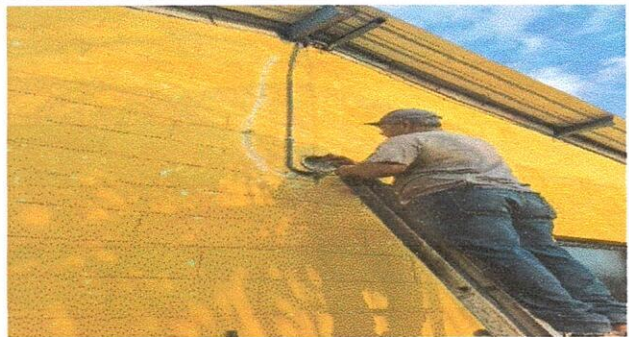
Foto 2: REPARACIÓN DE CABLEADO ELÉCTRICO
