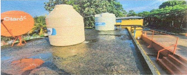
Foto 19: IMPERMEABILIZACION DE LOSA
