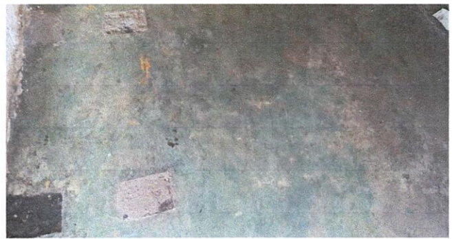
Foto 4: SUSTITUCION DE PISO DE CEMENTO LIQUIDO
