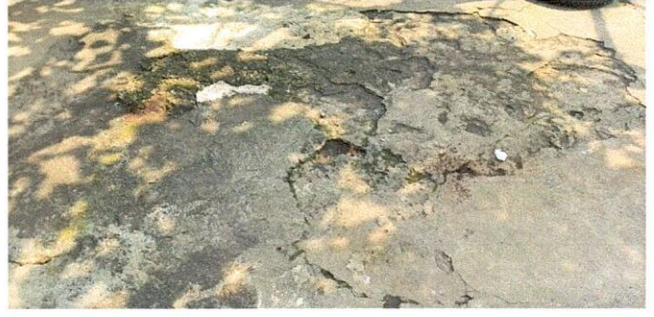
Foto 14: REPARACION DE PLANCHAS DE CONCRETO DE PATIO
