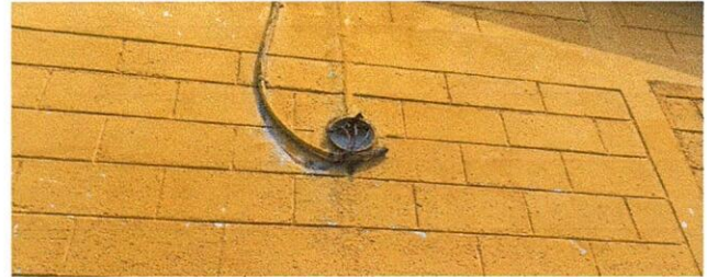
Foto 2: REPARACIÓN DE CABLEADO ELÉCTRICO
