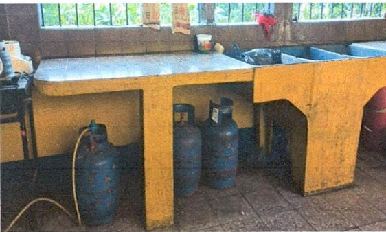
Foto 5: SUSTITUCION DE PISO DE GRANITO
