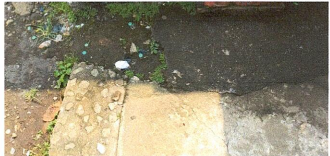
Foto 10 SUSTITUCION DE TUBERIAS PVC LINEA PRINCIPAL AGUAS NEGRAS
