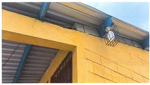
Foto 15: SUSTITUCION DE FOCOS AHORRADORES
