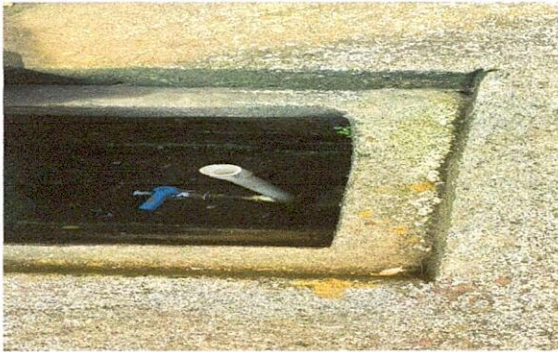
Foto 9: MANTENIMIENTO DE REPOSADERAS
