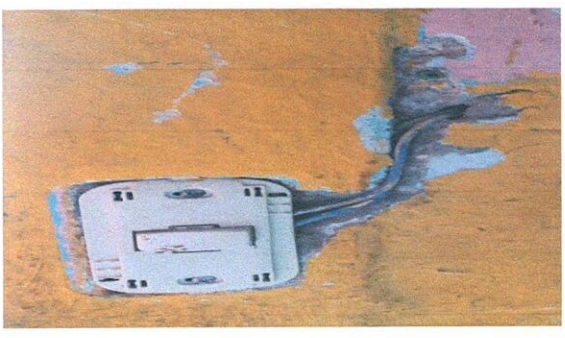
Foto 17: SUSTITUCIÓN DE INTERRUPTORES SIMPLES
