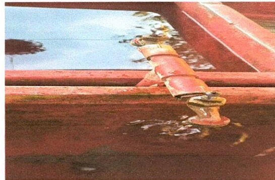
Foto 12: SUSTITUCIÓN DE LLAVE DE CHORRO
