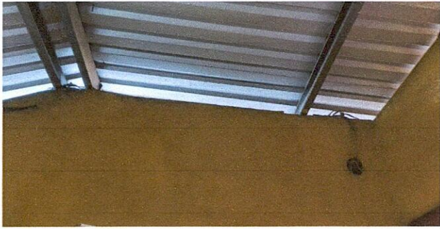
Foto1: SUSTITUCION DE LAMINA POR LAMINA TROQUELADA
