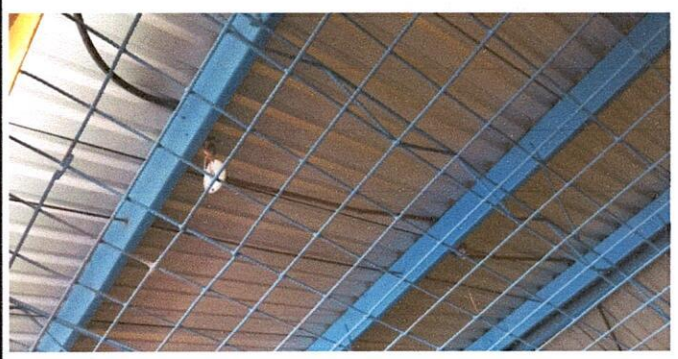
Foto 16: SUSTITUCION DE PLAFONERAS
