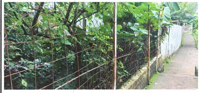
Foto 13: REPARACION DE TUBO HG MALLA GALBANIZADA
