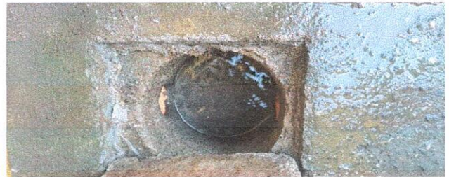
Foto 20: MANTENIMIENTO DE REPOSADERAS
