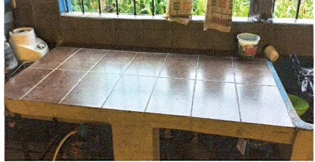
Foto 8: SUSTITUCIÓN DE AZULEJO
