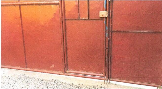
Foto7: MANTENIMIENTO A PORTONES DE METAL
