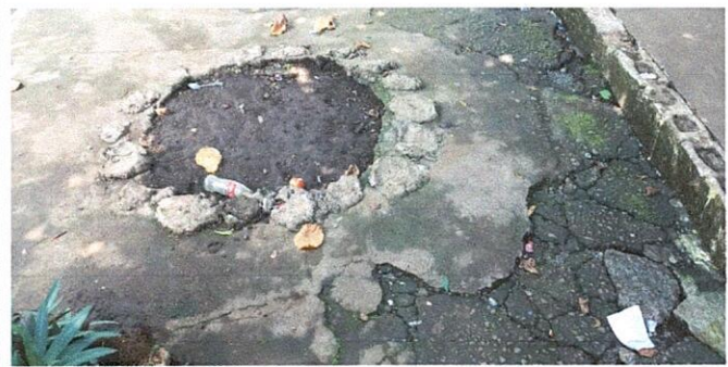
Foto 6: REPARACION DE BANQUETAS DE CONCRETO
