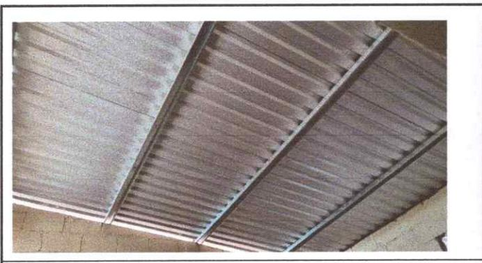
Foto: Sustitución de lámina troquelada aluzin calibre 26
