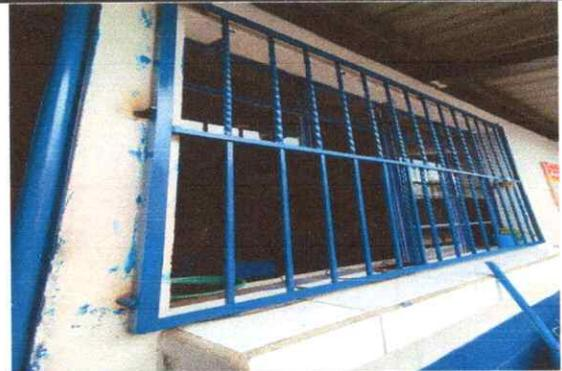
Foto 3: 5. 2 Sustitución de estructura de metal de ventana
