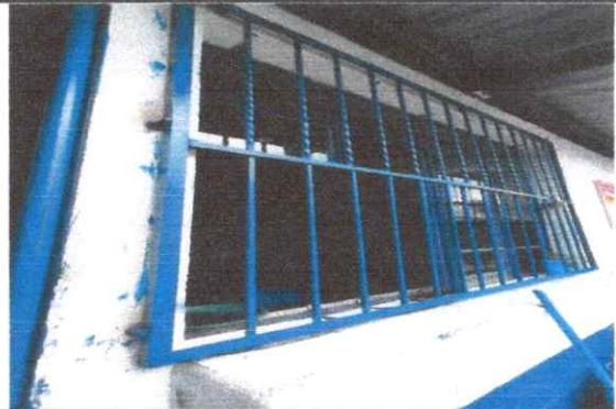
Foto 2: 5. 2 Sustitución de estructura de metal de ventana
