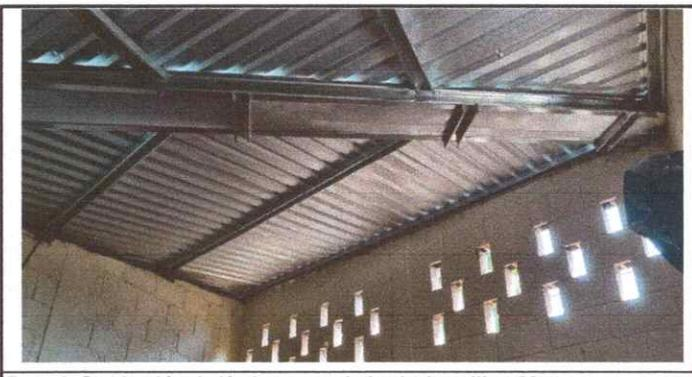
Foto 6. Sustitución de lámina troquelada aluzin calibre 26
