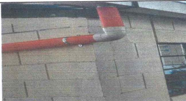
Foto 4: 7.2 sustitución de canal de pvc
