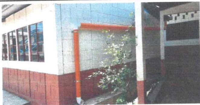
Foto 1: 7.2 sustitución de canal de pvc
