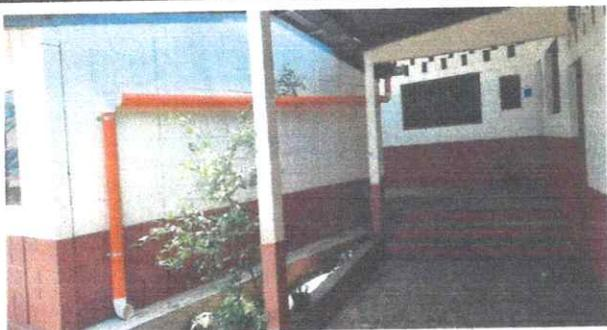
Foto 3: 7.2 sustitución de canal de pvc
