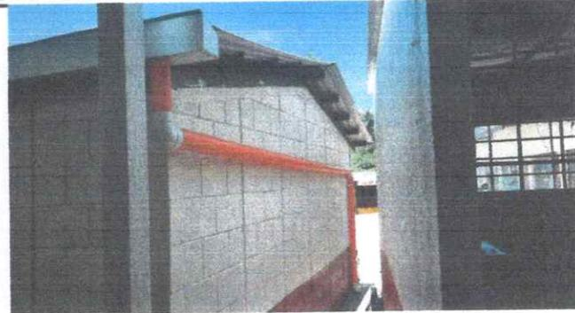
Foto 2: 47.2 sustitución de canal de pvc
