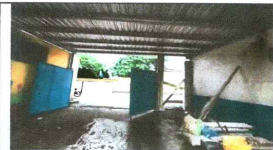
Foto 6. Sustitución de portón de metal
