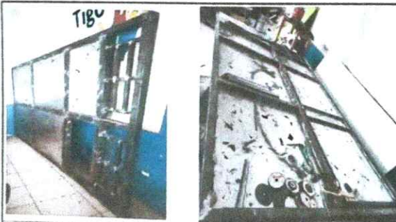
Foto 5: 5.4.5 Sustitución de portón de metal
