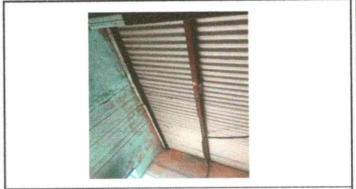
Foto 2: 1.1 Sustitución de lamina por lamina, troquelada aluzinc calibre 26. 1.3 Sustitusion de elementos de fijación.
