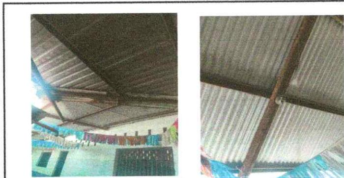
Foto 3: 2.3 Sustitución de estructura de soporte de metal por metal.
