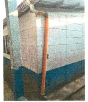
Foto 8: 7.1 Sustitución de canal de metal 7.2 Sustitución de canal de pvc
