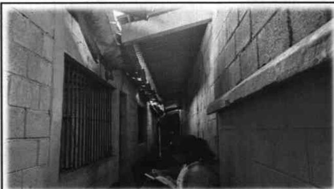
Foto 10: Es importante el cambio e instalación de bajadas de agua pluvial, soportes para canal y canal PVC.
