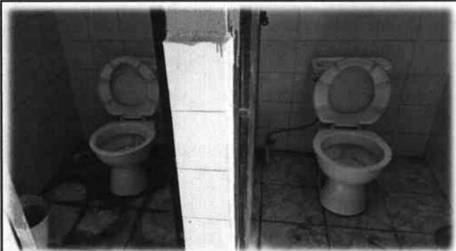
Foto 3: Es necesario el cambio e instalación de inodoros, incluye accesorios y conexión de tubería
