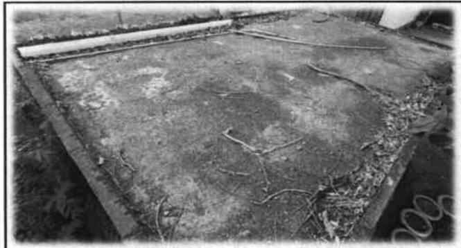
Foto 6: Es necesaria la reparación de pañuelos en losa de concreto, impermeabilización y reparación de bordes de goteo.
