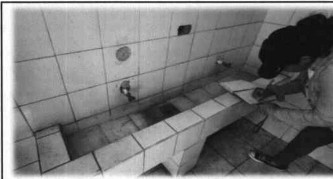
Foto 5: Existe la necesidad del cambio e instalación de azulejo en los lavamanos del módulo de servicios sanitarios.
