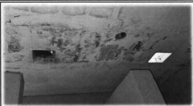
Foto 7: Es necesaria la reparación de circuito de iluminación (incluye ducto o tubo PVC, abrazaderas, cajas octogonales, cables, interruptores, plafonera con foco ahorrador de alta potencia).
