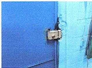
Foto 5: Sustrucción de estructura de chapa
