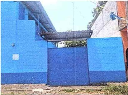
Foto 3: Mantenimiento a porton de la escuela
