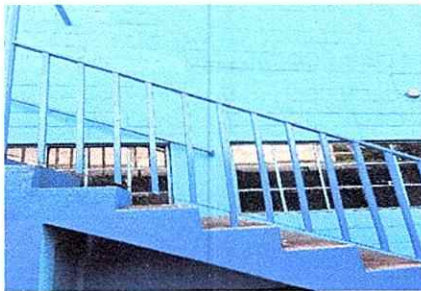
Foto 5: Mantenimiento a barandas de metal
