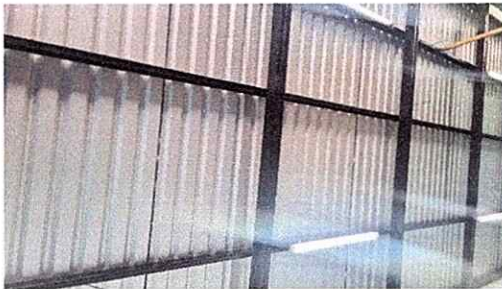
Foto 3: Mantenimiento a estructura de soporte metalico
