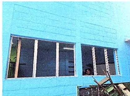
Foto 2: Sustitucion de estructura de metal de ventana.
