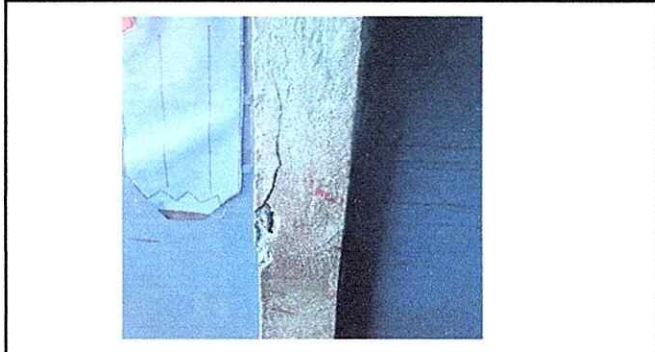
Foto 4: Sellado de grietas y fisuras de muros.
