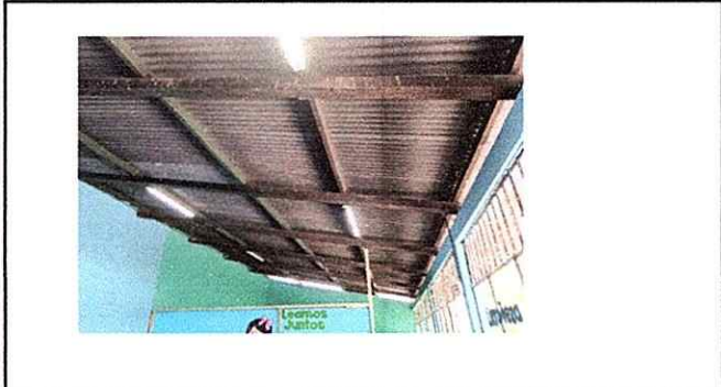
Foto 3: Mantenimiento a estructura de soporte metalico
