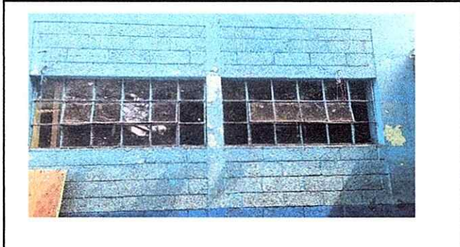
Foto 2: Sustitucion de estructura de metal de ventana.
