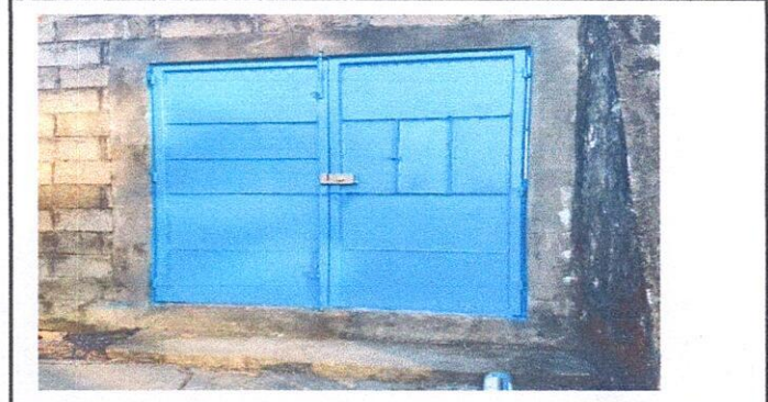
Foto1: 4.1 Mantenimiento a estructura(lijado,cambio de tubo,cepillado, sujeciones, aplicación de pintura) Finalización de la reparación de puerta principal, acceso peatonal.
