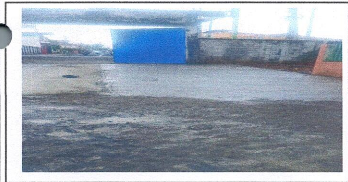
Foto 5: 16.1 Reparación de planchas de concreto de patio.La realización de losa de patio evitará que los visitantes sufran algun accidente a su ingreso o egreso al establecimiento.
