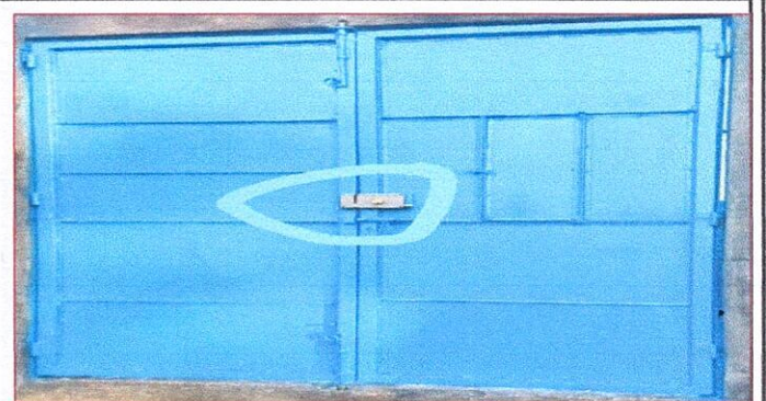
Foto 2: 4.2 Sustitución de chapa. El cambio de chapa en puerta peatonal, fue necesario puesto que la anterior no permitía quitar llave.
