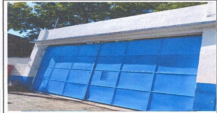
Foto 3: 12.1 Mantenimiento a portones de metal Finalización de reparación de portón principal de la escuela-
