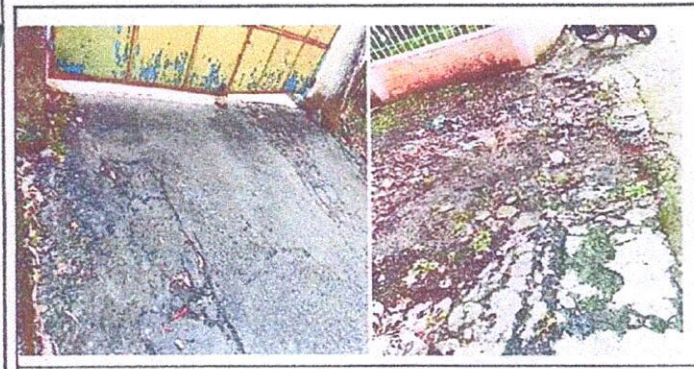
Foto 5: 16.1 Reparación de planchas de concreto de patio
