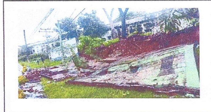
Foto 4: 15.1 Reparación de muro perimetral de block
