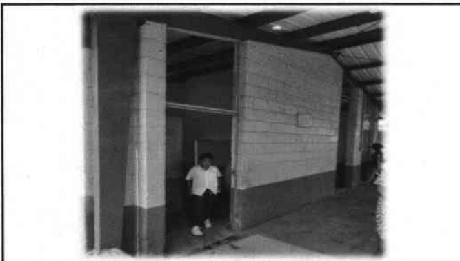
Foto 5: Reparación y mantenimiento de puertas, incluye pintura y chapa, cambio de vidrio en la parte superior de las puertas principales de ss. Niños y niñas
