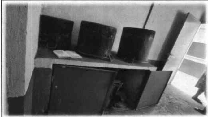
Foto7: Mejoramiento de cocina, incluye muebles fijos de concreto, y azulejo.
