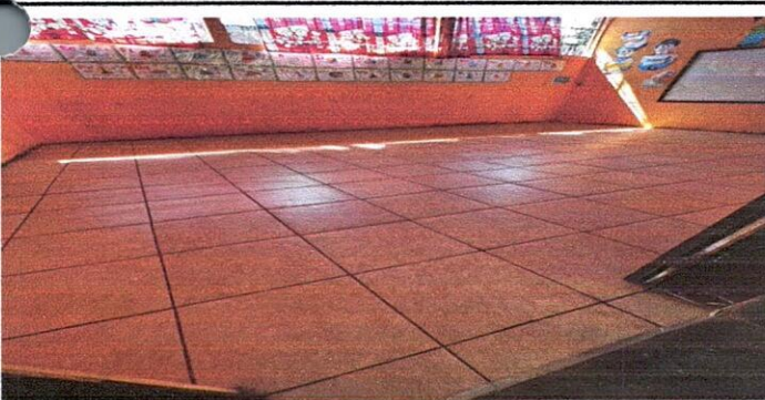
FOTO:5 Sustitución de piso Cerámico 100 %.
