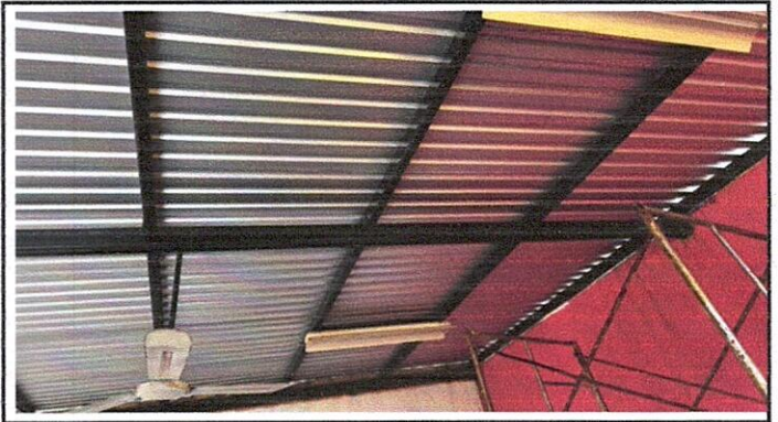
FOTO:4 Mantenimiento a estructura de Soporte de metal. 100 %.
