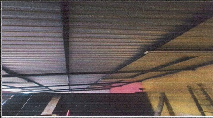
FOTO:1 Sustitución, por lámina Troquelada, aluzinc calibre 26. 100 %.
