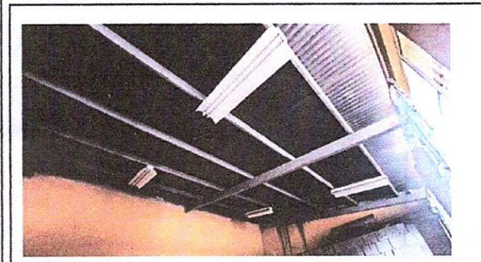
FOTO 3: Mantenimiento a estructura de soporte de metal
