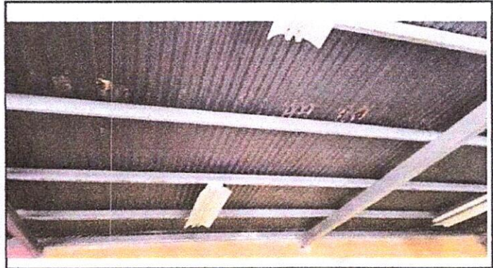
FOTO 2: Sustitución de lámina, por lámina troquelada, Aluzinc calibre 26
