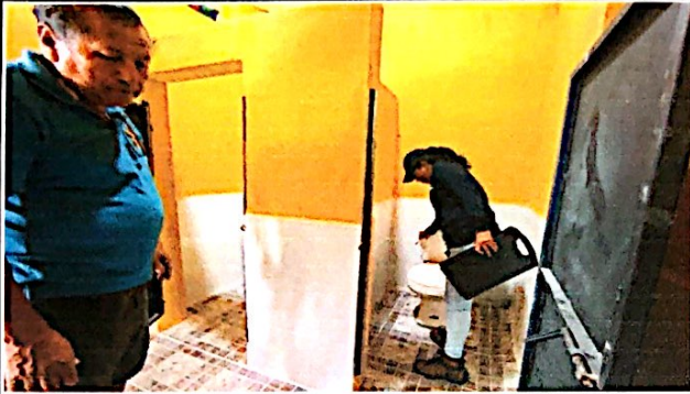
Foto 7: Reparación del 3r. Modulo de servicio sanitarios, la evaluadora de campo supervisa que no haya fugas en los inodoros.
