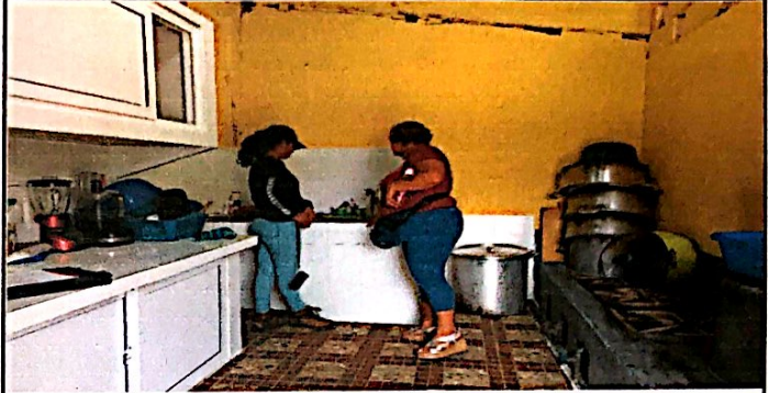
Foto 8: Mejoramiento en modulo de cocina, se realizaron distintos trabajos como: instalación de muebles fijos de cocina y mejoras en estufa rural, la evaluadora de campo da por finalizado al 100%.
