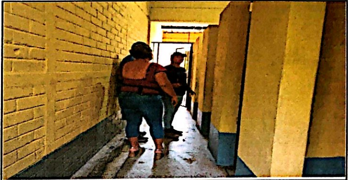
Foto 2: Reparación del 1r. Modulo de servicio sanitarios, donde incluye cambio de tubería y reparación de sistema electrico entre otros.
