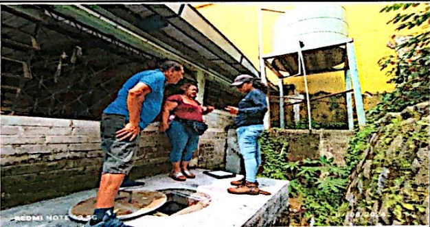
Foto 9: Se repara losa superior de cisterna ya que se encontraba en pesimas condiciones, logrando el 100% en su ejecución.
