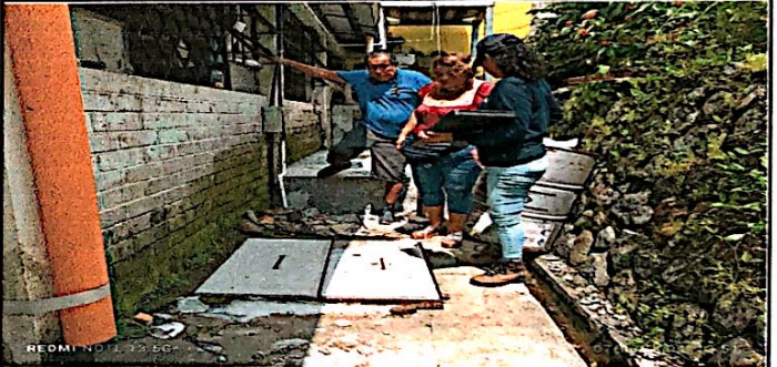
Foto 10: Cambio e instalación de bomba para pozo incluye accesorios y conexión, se contempla el 100% de las mejoras en el renglon 5.1 y 5.2 de la PRA-FOR-85.
