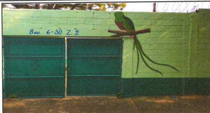
Foto 1: Demoler 6 hiladas de Block.
