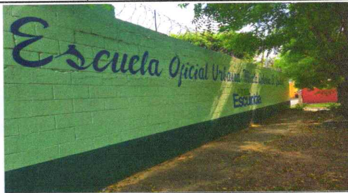
Foto 2: Colocacion de 8 columnas y subir 6 hiladas mas.
