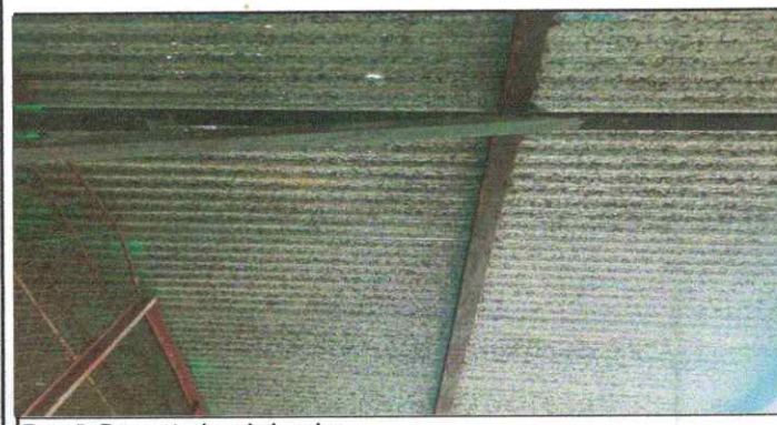
Foto 5: Desmotacion de Lamina
