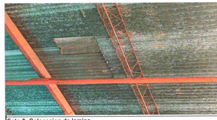
Foto 6: Colocacion de lamina
