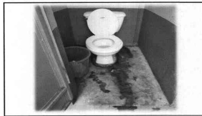
Foto 6: Es necesaria la reparación de módulos de servicios sanitarios de mujeres, incluye: artefactos, tuberías, accesorios y azulejos
