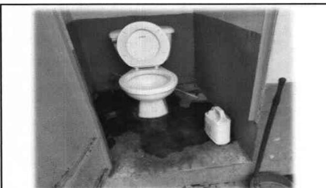
Foto 3: Es necesaria la reparación de módulos de servicios sanitarios de hombres, incluye: artefactos, mingitorios tuberías, accesorios y azulejos.
