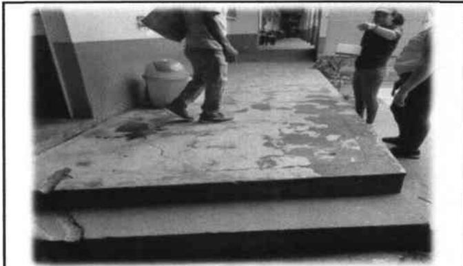
Foto 10: Es necesario el cambio e instalación de piso antideslizante.
