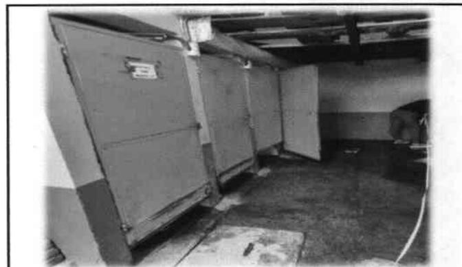
Foto 4: En el módulo de servicios sanitarios para hombres, es necesaria la reparación y mantenimiento de puertas metálicas.
