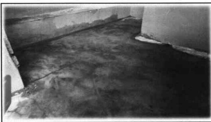
Foto 5: Mejoramiento módulo de servicios sanitarios de hombres con el cambio e instalación de piso antideslizante.
