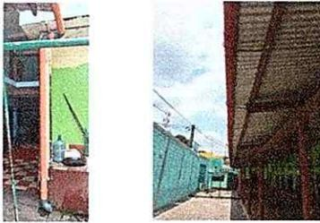
Colocación tubos bajada de agua, mantenimiento y reparación de canales.
