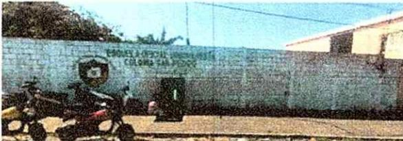
Foto 1: Muro perimetral, inclinado no tiene columnas, peligro latente de colapso.
