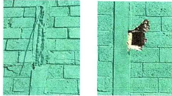
Foto 2: Columnas en malas condiciones, reparar grietas, rajaduras y agujero
