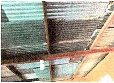
Foto 3: Lamina con agujeros en mal estado, se filtra el agua cuando llueve.
