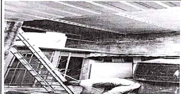
FOTO 2: SUSTITUCIÓN DE ESTRUCTURA DE TECHO
