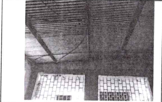
Foto 1: Cambio de costaneras y laminas por lamina troquelada y costanera de mayo espesor.
