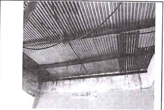
Foto 3: Cambio de costaneras y laminas por lamina troquelada y costanera de mayo espesor.
