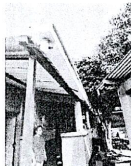
Foto 2: Reparación de bajadas de agua pluvial.
