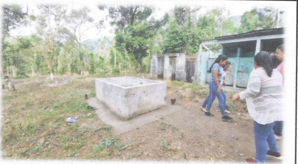
Foto 9: Reparación e instalación de cubierta en pileta, que se encuentra cerca de los servicios sanitarios lado norte de la escuela.
