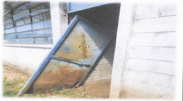
Foto7: Mejoramiento y Reparaciones en el modulo de cocina y bodega. Tambien incluye cambio de puerta de metal en bodega y balcon.
