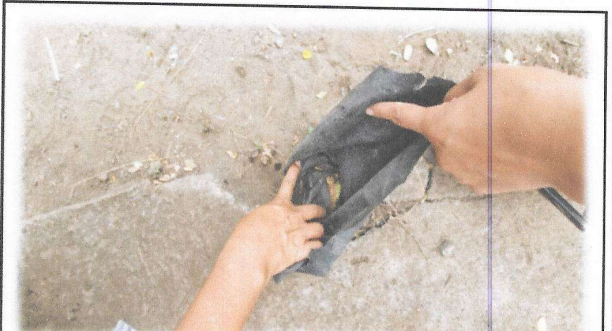
Foto 10: Bases actuales de madera para la cubierta en pileta. Eran de madera, pero por cuestiones climaticas se han caído y deteriorado.
