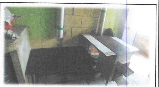
Foto 6: Mejoramiento y Reparaciones en el modulo de cocina y bodega. Incluye sustitución de poyeton, reparaciones de muebles de cocina y bodega de almacenamiento.
