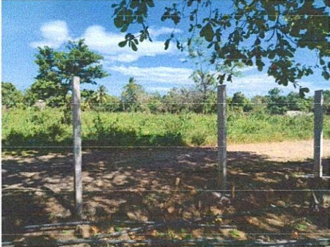
Foto 7: Reparación de cercode alambre de púas
