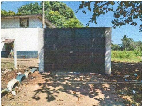
Foto 9: Fabricación e instalación de portón de metal de ingreso
