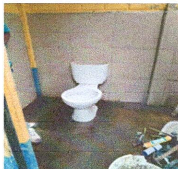
Foto 4: Sustitución de inodoro
