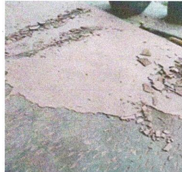
Foto 2: Sustitución de piso
