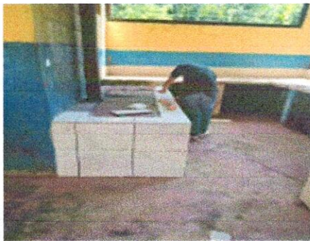
Foto 11: Instalación de azulejos en estufa rural
