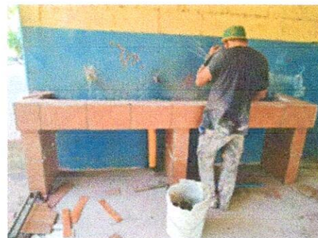
Foto 6: Sustitución de azulejo
