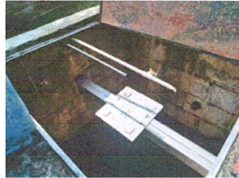
Foto 8: Sustitución de bomba de agua
