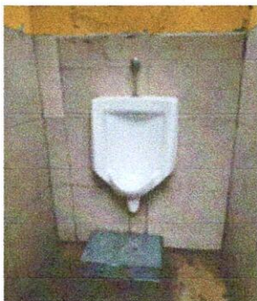
Foto 5: Sustitución de migitorio
