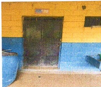
Foto 5: Suministro e instalación de puertas de metal con chapa
