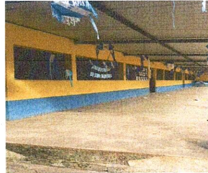
Foto 2: Sustitución de piso de cemento líquido
