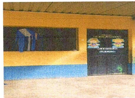
Foto 4: Suministro y aplicación de pintura exterior
