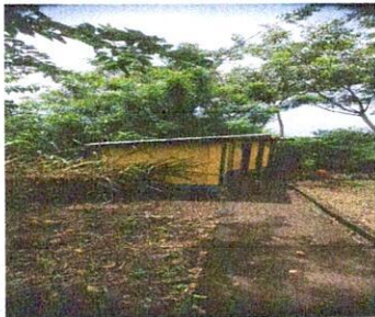
Foto 1: Sustitución e instalación de lámina en el área de baños
