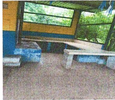
Foto 10: Suministro e instalación de azulejo
