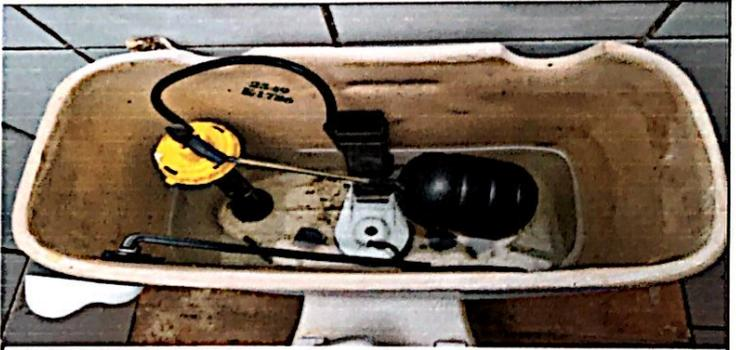
Foto 4: Sustitución de Kit de repuestos para tanque e instalación de inodoro, finalizado al 100%
