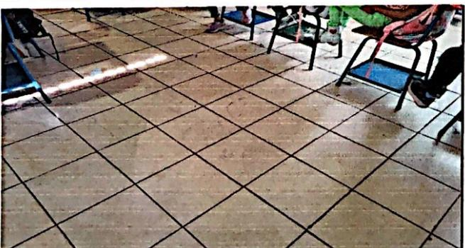
Foto 11: Sustitución de piso de concreto a piso cerámico antideslizante en salón ubicado al costado del área de cocina (6.20 m x 7.10). Finalizado al 100%
