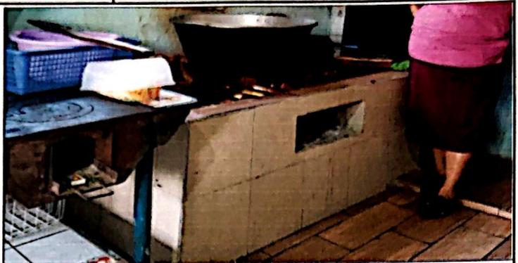
Foto 2: Mejoramiento de cocina, incluye remozamiento de estufa de leña rural, cambio de pila y reparación de drenaje, reparación de muebles de cocina e instalación de azulejo. Finalizado al 100%
