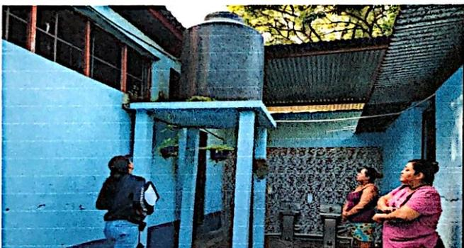
Foto 9: Sustitución e instalación de depósito de agua de 1100 lts, finalizado al 100%
