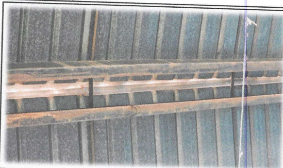
Foto 8: Una de las prioridades en el módulo de aulas es el mantenimiento a estructura de soporte de metal (lijado, aplicación a 2 manos de pintura anticorrosiva).
