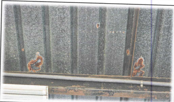
Foto 10: Es importante el cambio e instalación de lamina troquelada aluzinc calibre 26. (Incluye capote y tornillos)
