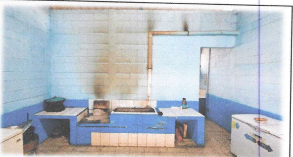
Foto 6: Cambio e Instalación de estufa de leña rural mas chimenea, y azulejo.
