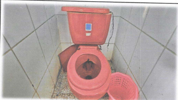
Foto 3: Mejoramiento en el 1er módulo de servicios sanitarios por medio del cambio e instalación de inodoros, incteye conexión y kit completo.
