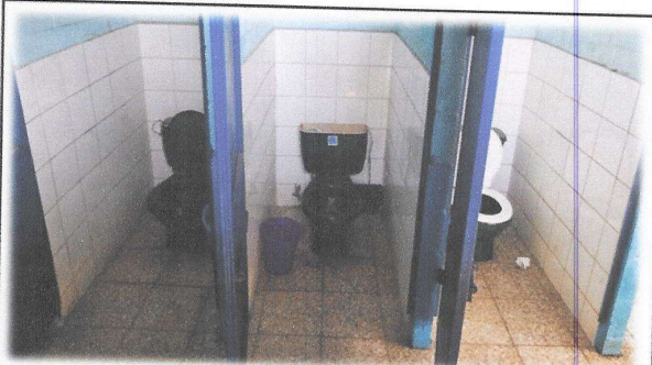
Foto 4: Mejoramiento en el 2do módulo de servicios sanitarios por medio del cambio e instalación de inodoros, incteye conexión y kit completo.
