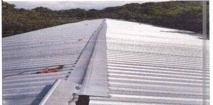
Foto 2: Evidencia del avance de la sustitución de capote, en los salones, dirección y baños.
