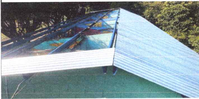
Foto 1: Evidencia del avance del cambio de techo de los primeros 3 salones, dirección, cocina, y baños de niños y niñas.
