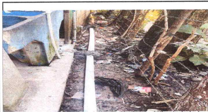
Foto 5: Evidencia del avance de la sustitución de tubería lineal principal.
